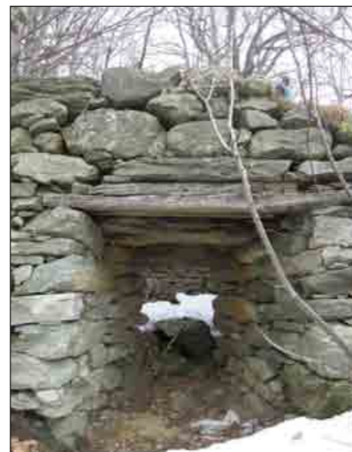
La bocca di alimentazione del forno di Anviev (Arnad)
