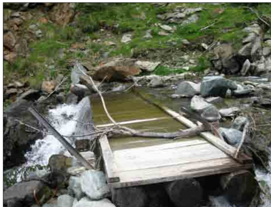
Vallone di Savoney, in comune di Fénis: il vecchio ponte era praticamente solo ostruito, sarebbero bastati un piccone, un palanchino e due ore di lavoro di un operaio, per liberarlo dai detriti e renderlo di nuovo funzionante.
