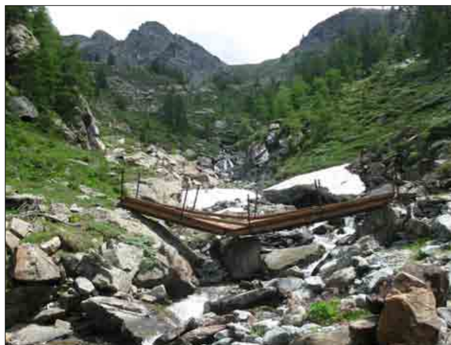
Vallone di Savoney, in comune di Fénis: il vecchio ponte era praticamente solo ostruito, sarebbero bastati un piccone, un palanchino e due ore di lavoro di un operaio, per liberarlo dai detriti e renderlo di nuovo funzionante.
